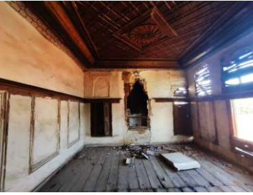
c) Odanın kuzey duvarı
