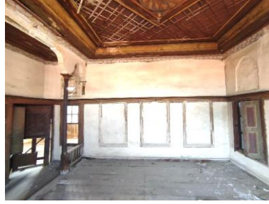
b) Odanın batı duvarı
