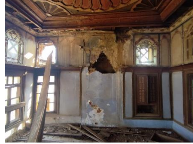
b) Odanın güney duvarı
