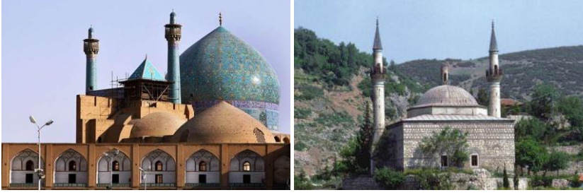
Şekil 6 İsfahan Mescid-i Cuma Kubbesi , Şekil 7 Bursa Orhan Gazi Camii ve Kubbesi
