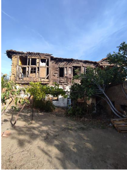
Resim 5 Hacı Kabakçılar Konağı arka cephe
