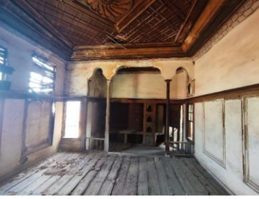
a) Odanın güney duvarı
