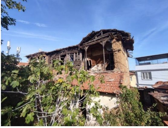
Resim 4 Hacı Kabakçılar Konağı Avlu Yönünden Görünüşü
